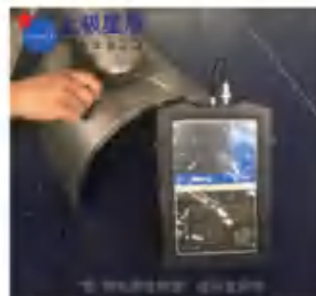
管-管对接焊缝超声探伤
